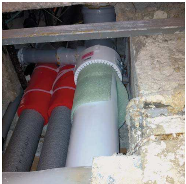
Aplikácia protipožiarna techniky, pohľad zo spodu pred zabetónovaním montážneho otvoru cez prestup podlaží
